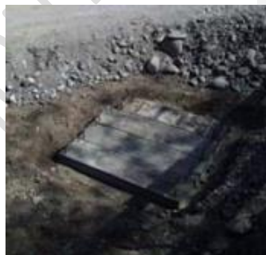
Abbildung 9 Kabelkanalisation: Plattenschacht oben
